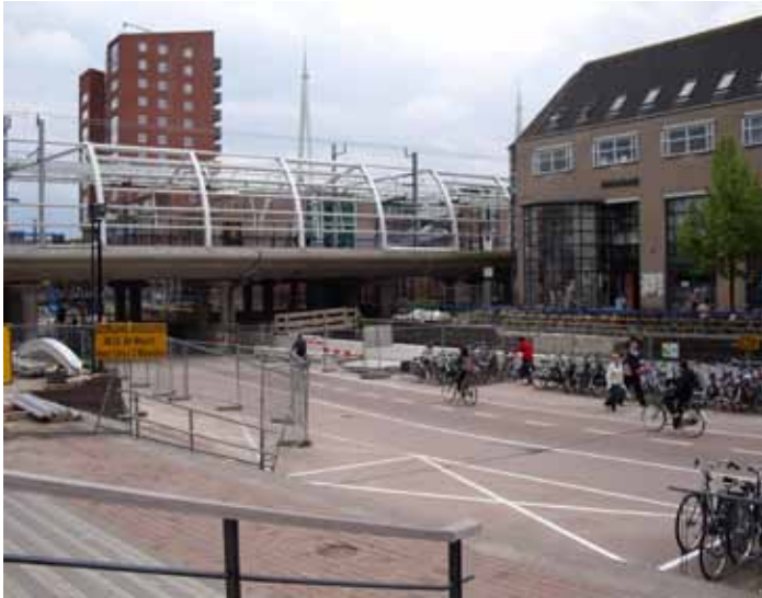
fietstransferium in aanleg onder sporen
